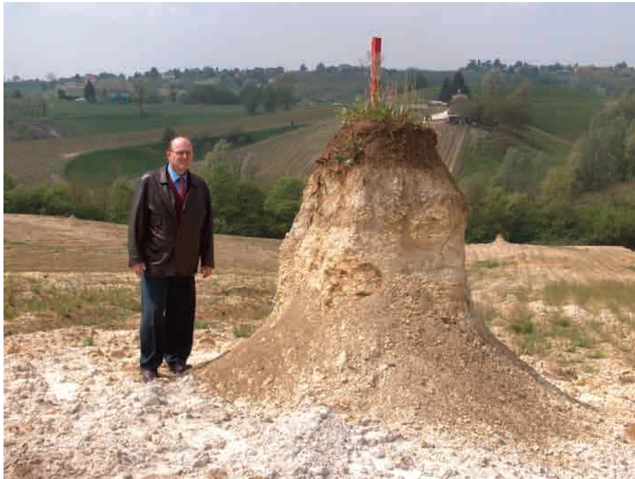
Figura 3.8 - Uno sbancamento effettuato per una profondità di più di 2 metri, pari a circa 34.000 t/ha di suolo asportato su una superficie molto vasta
