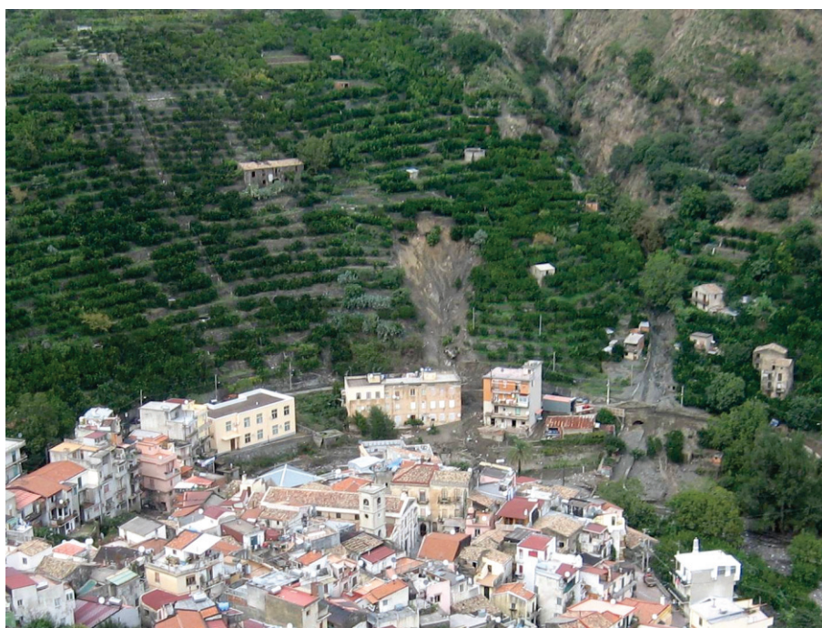
Figura 3.6 - Frana superficiale su terrazzamenti, Altolia (ME)
